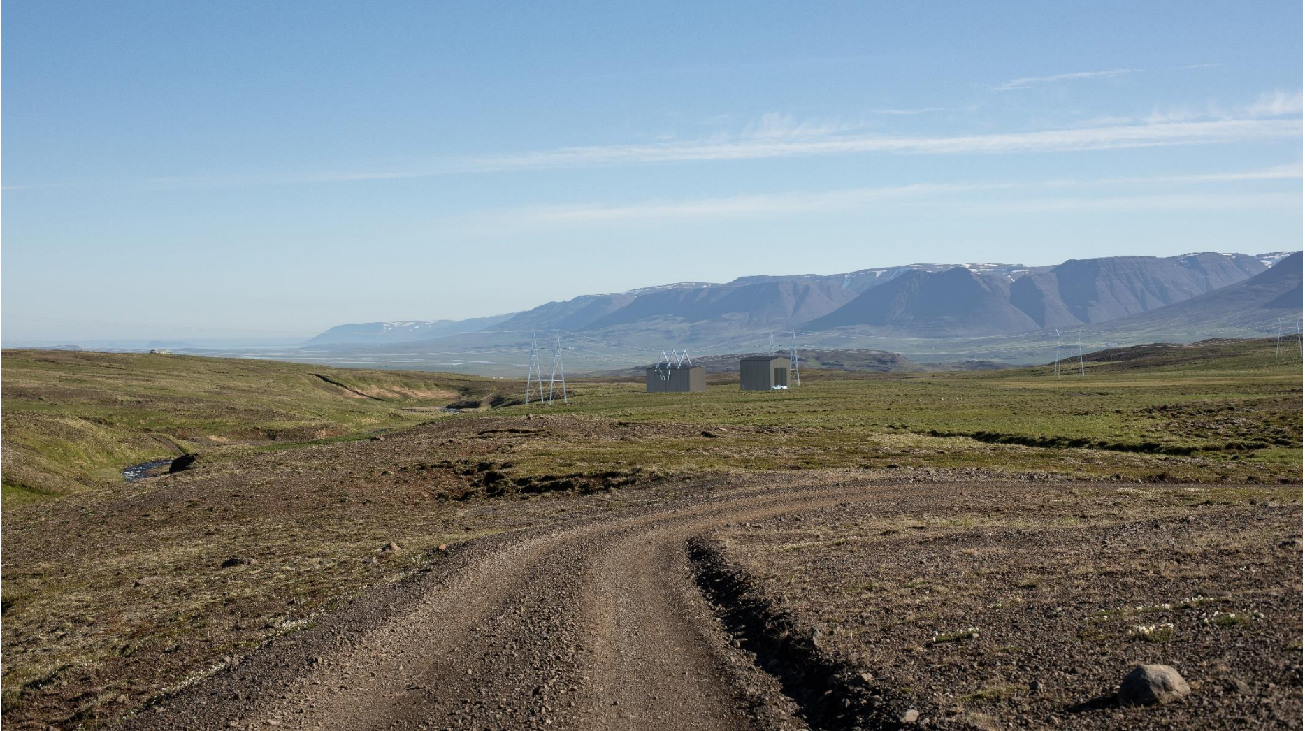
Mynd 3.7 Tölvumynd af fyrirhuguðu tengivirki í Skagafirði í landi Mælifells. Tengivirkið samanstendur af spennasal (20x 9,5 m og 9 m hæð) og rofasal (13,x13 m og 12 m hæð).
